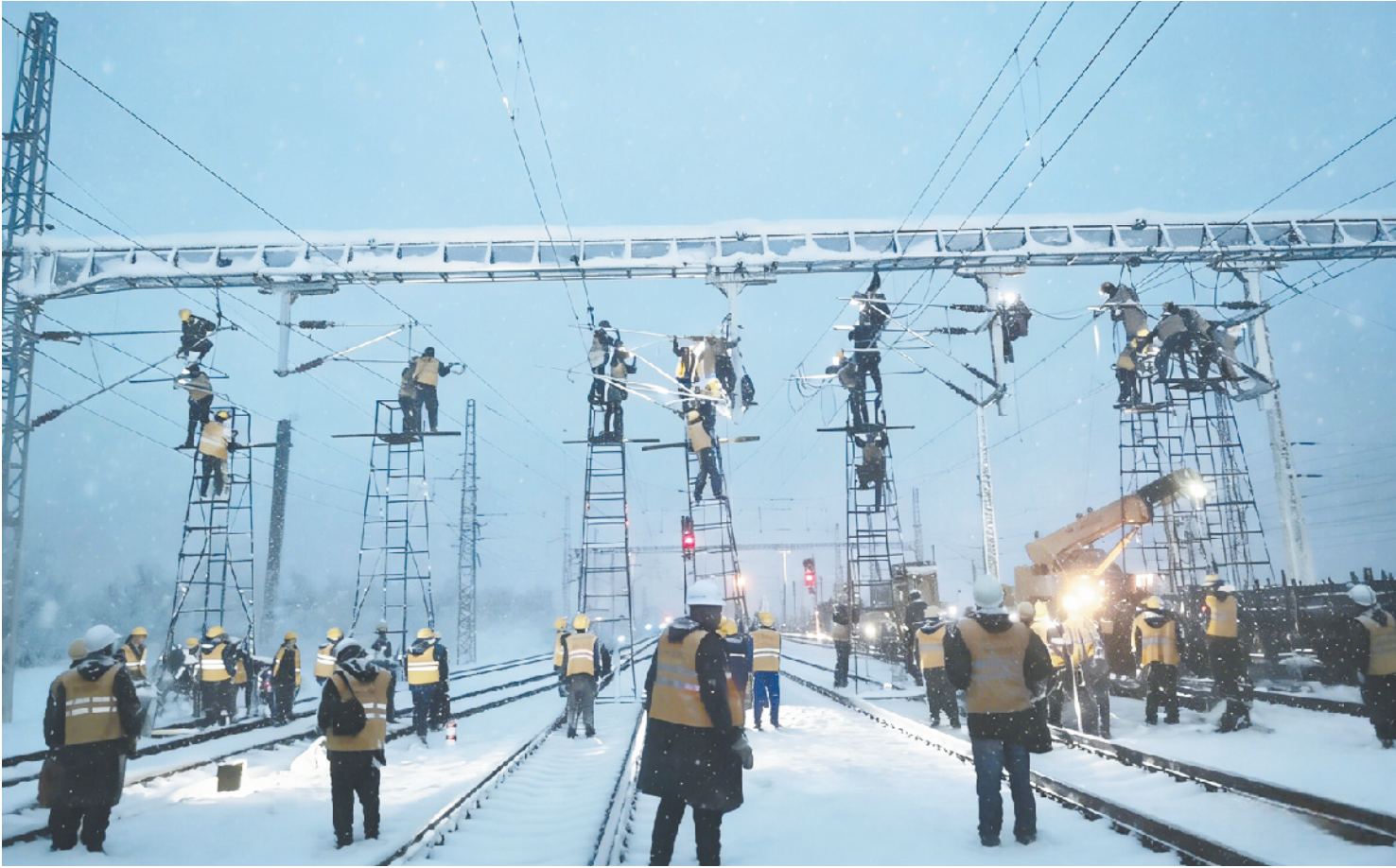
施工人员在哈大线大修工程现场进行接触网调整
