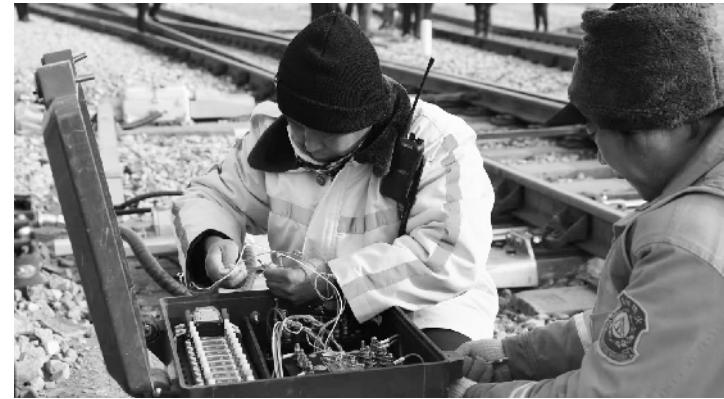
冬日的清晨,唐山东站区寒意袭人。中国铁路北京局集团北京工电大修段100余名干部职工已在驼峰峰尾现场集结完毕,清点工具、核对图纸。他们要在接下来的210分钟里,为这套站场的“神经中枢”——联锁设备完成一次大升级。
