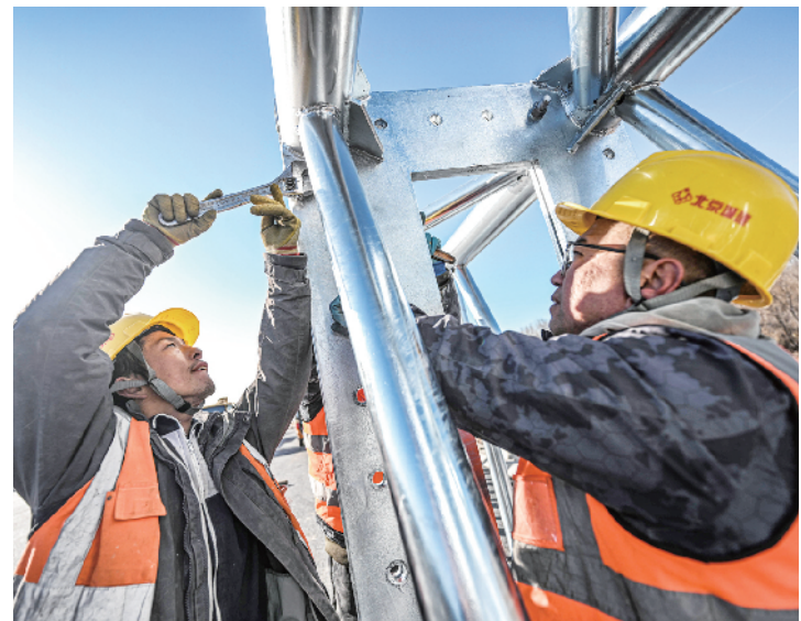
工人在安装路标指示牌架
