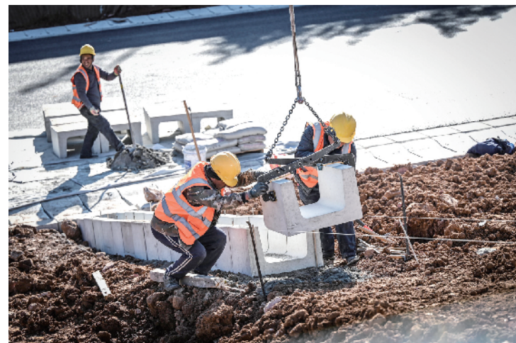
工人在铺设好的高速旁安装U型预制混凝土排水槽
