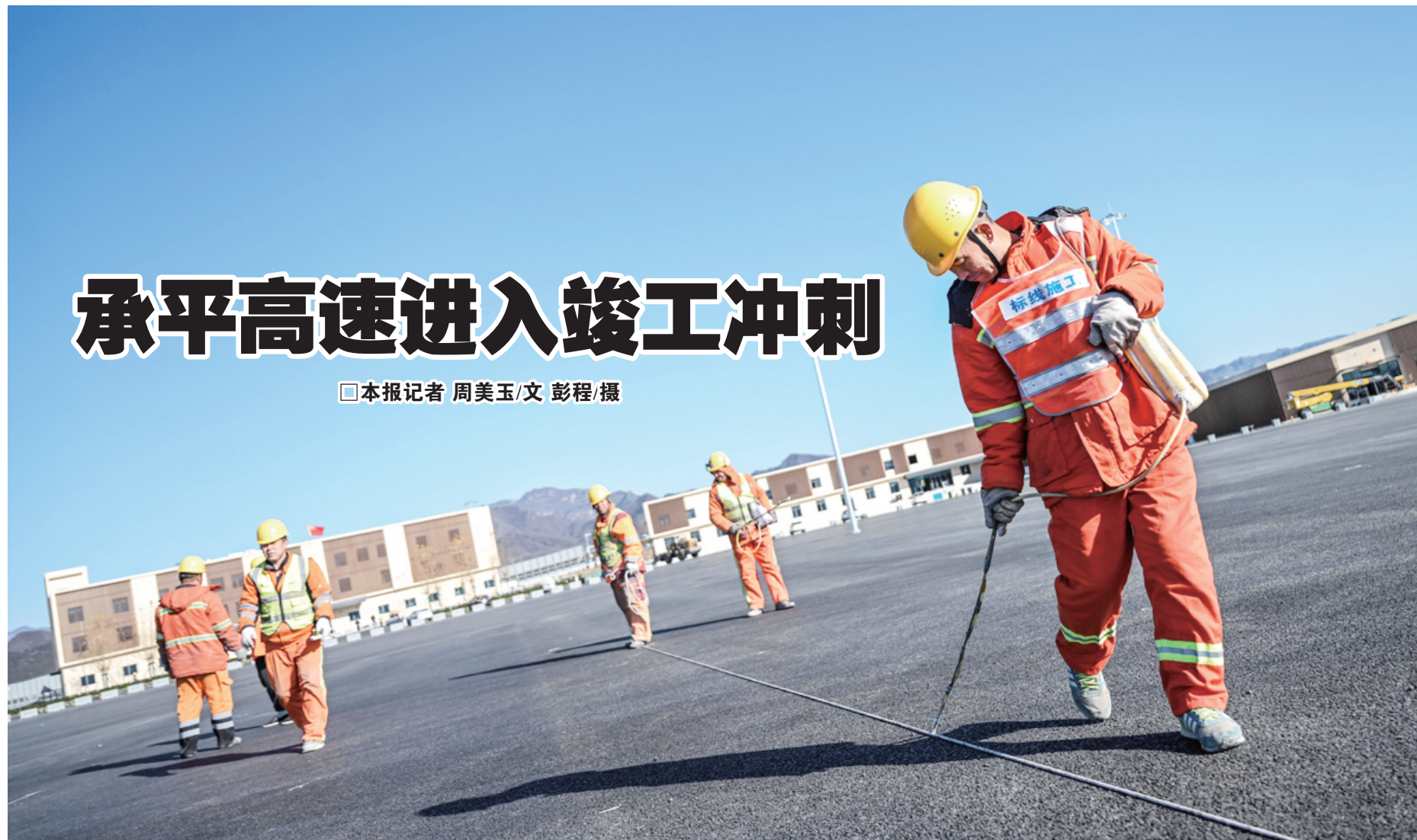
工人在崭新的路面划线
