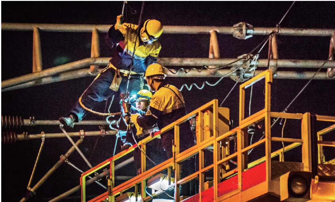
夜间，作业人员利用作业车进行接触网设备检查
