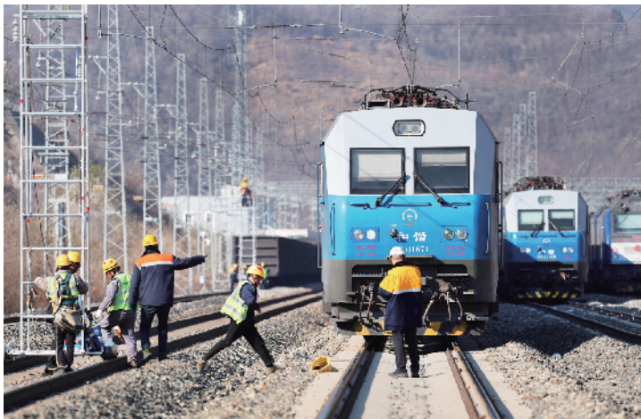
作业人员利用每日“天窗”检修时段，在接触网上检修作业
