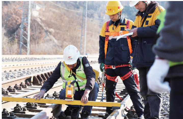
作业人员进行接触网参数测量作业
