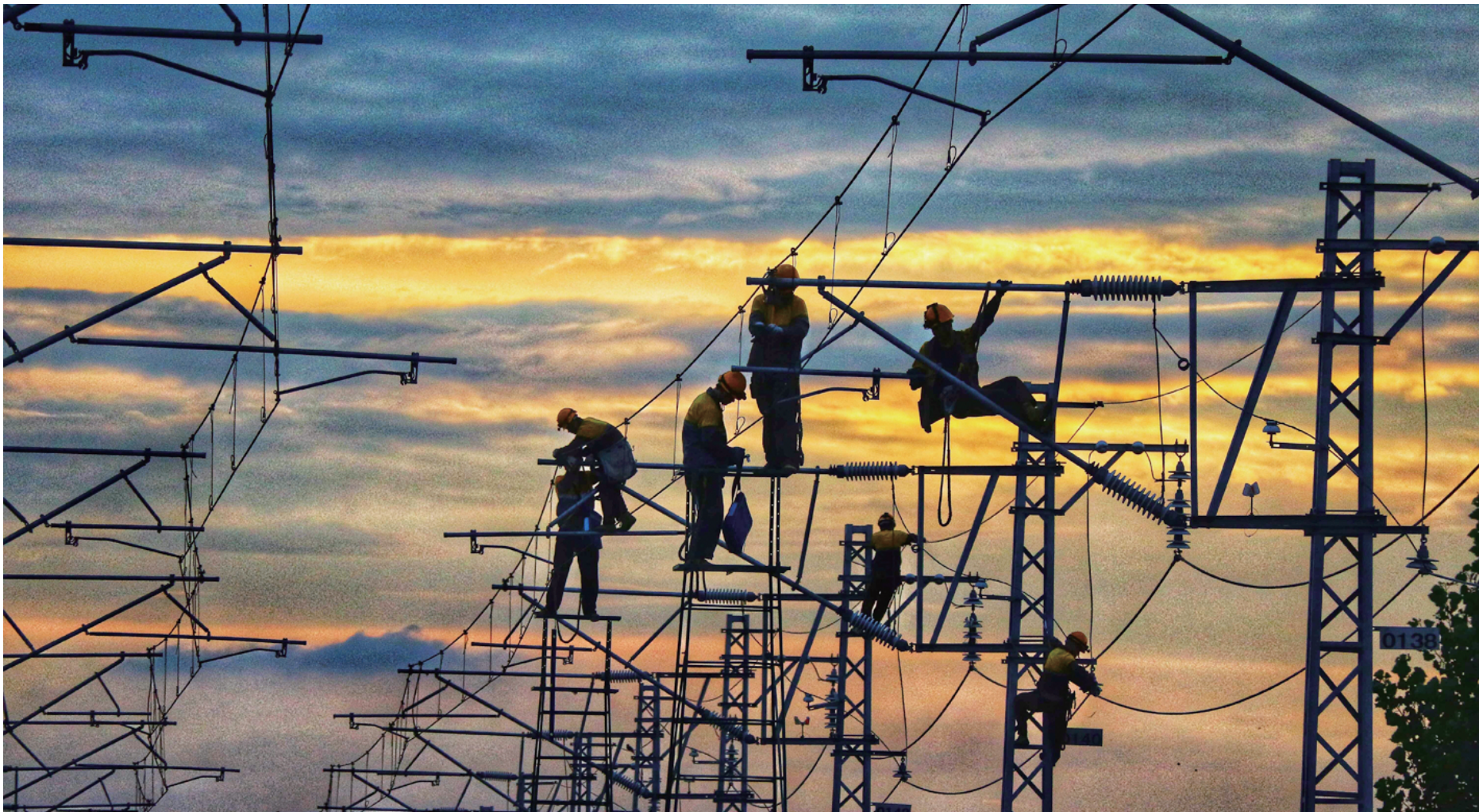
作业人员进行接触网设备检修作业
