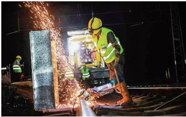
职工正在对铁轨焊缝进行打磨
