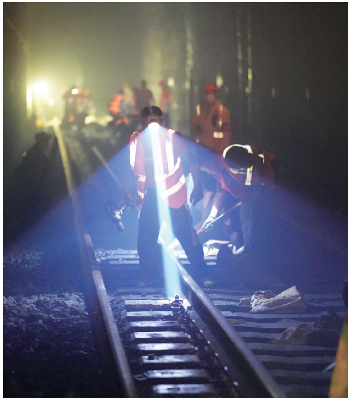
职工们拆卸旧扣件，为后续机械换轨施工争取时间
