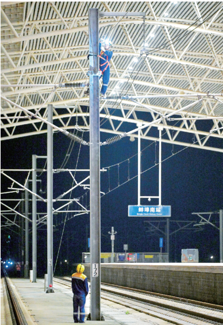
在做好防护措施的情况下，作业人员攀爬11米H型钢柱进行高空作业
