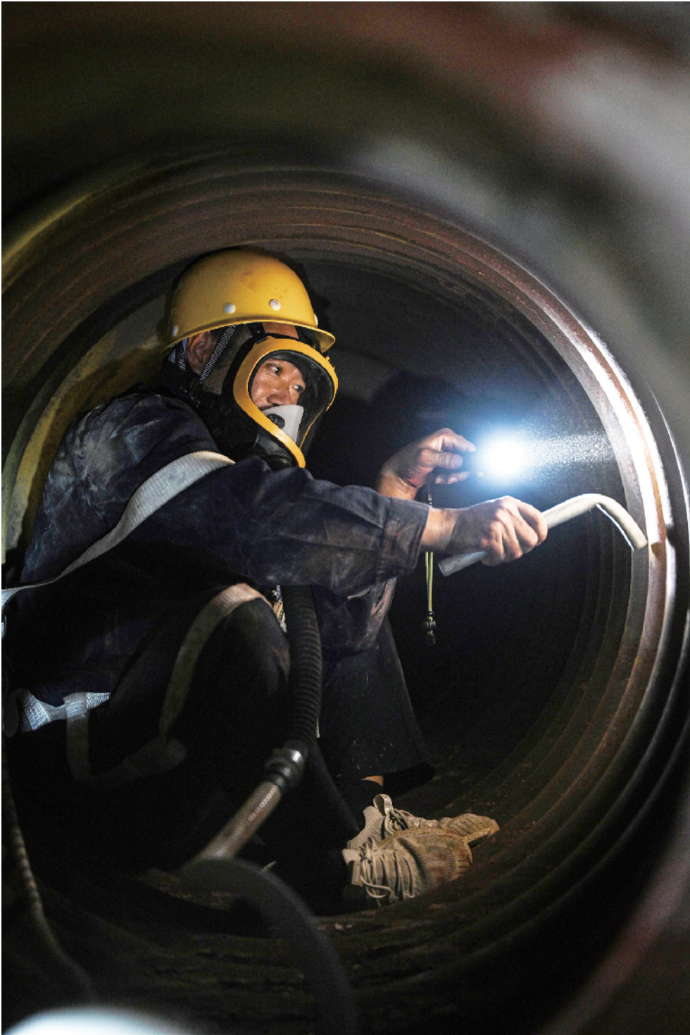
炉内空间十分狭小闷热，检查清理工作往往要在里面持续一个小时
