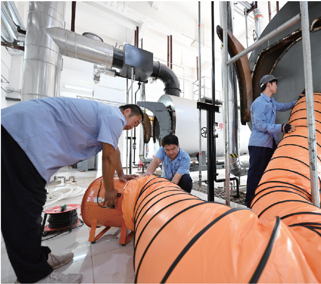
作业前，职工们安装轴流风机，将风机上的通风管与锅炉检查口连接起来，对炉膛内部通风换气
