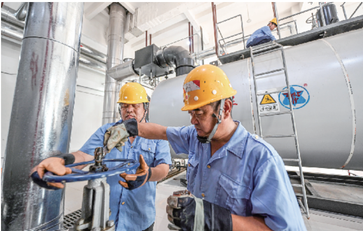
职工们往阀门螺杆涂抹黄油，确保冬天使用检修阀门时开关灵活
