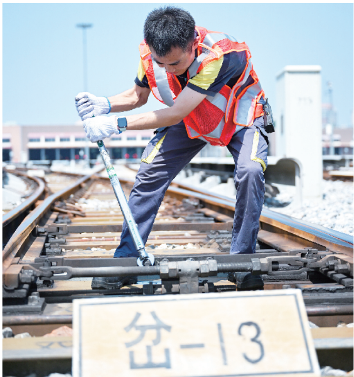
京港地铁职工对转辙机结构进行紧固检查
