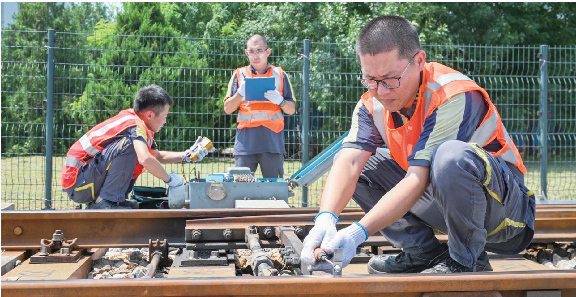
京港地铁职工对转辙机进行电气参数测试
