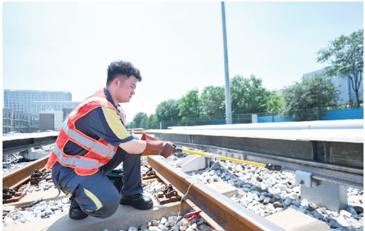
京港地铁职工对接触轨进行验电试验
