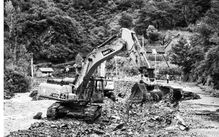
根据实际情况制定了沿河道重新导改道路的方案,每隔一段距离,就有几台挖掘机同时作业,或填充河道,或填补水毁公路。村民们看到抢通队伍,主动向施工人员介绍当地地质情况,帮助施工队伍快速掌握地势地貌。
