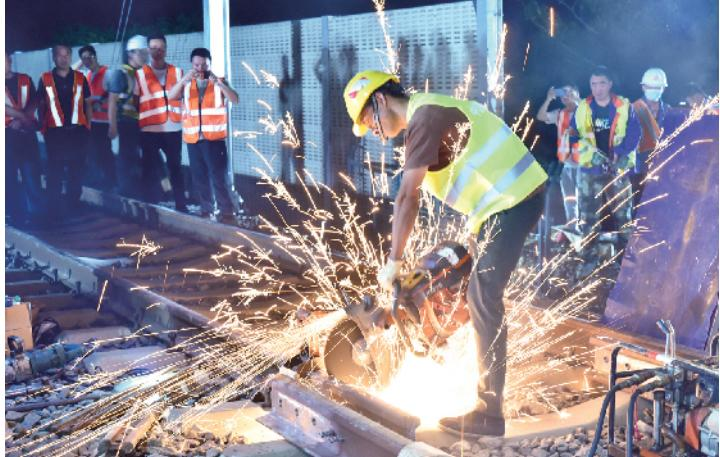
证人机安全,又要保证铁路行车设备稳定,这给本次施工带来了很大挑战。为确保道岔精准就位,项目团队在施工前通过BIM技术对插铺作业进行推演,以分钟为单位精细卡控各流程、环节,
