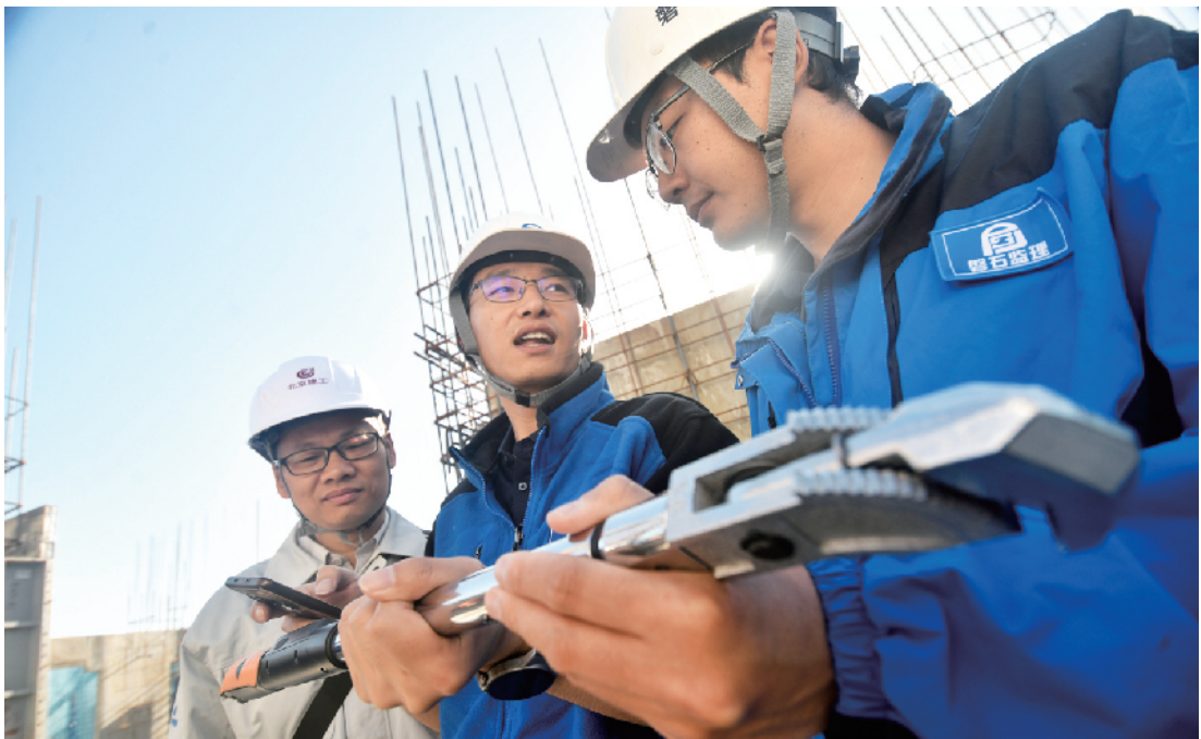
测量前，对智能扳手进行校准
