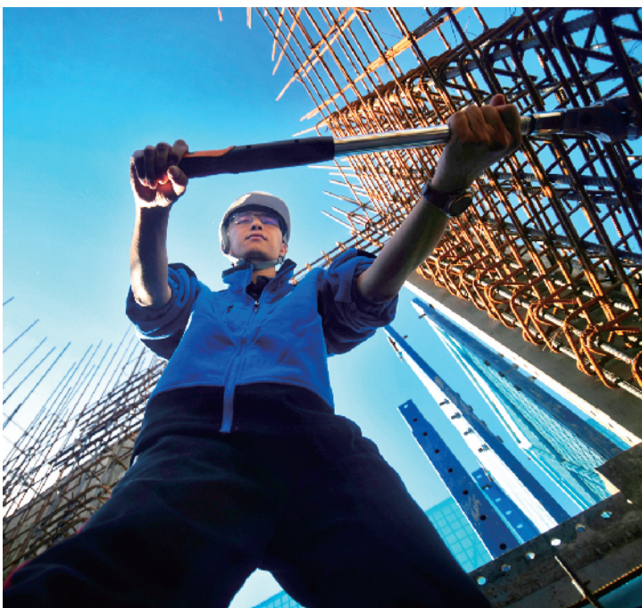
职工使用智能扳手进行测量作业
