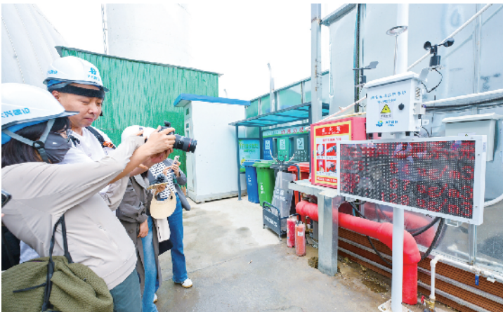
工地现场安装了多处扬尘在线监测系统，数据实时播报
