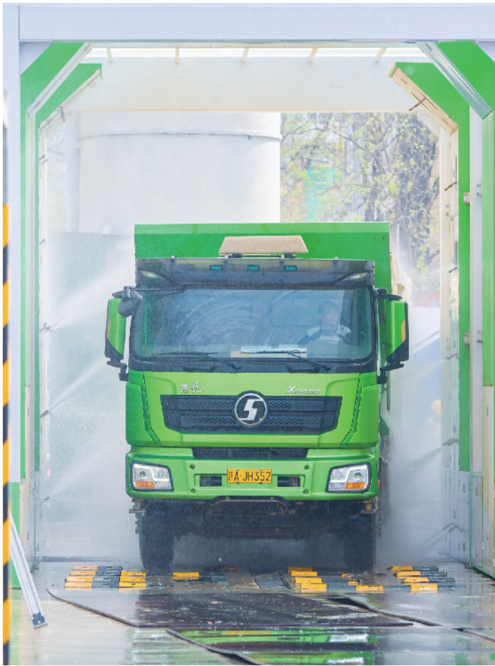
每一辆渣土车都要进行360度冲刷后才能驶离施工现场
