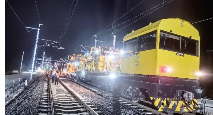
近日，随着最后一处接触网参数测量数据达标，雄安枢纽工程米宁庄线路所接触网承导线更换任务顺利完成，为雄安枢纽工程米宁庄线路所按期开通打下了坚实基础。
