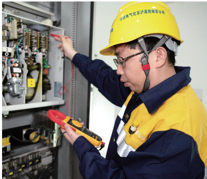
核算,发现其误差分布与故障位置存在一定关联,但因数据量太少无法确定症结。为了彻底摸清楚故障测距精度不佳的原因所在,他自行研发了同步电流采集设备,将机车电流数据模拟为故障数据,一举将基础数据量从几十个提升到了数万个。通过对这些海量数据进行分析,发现故障测距装置中的Q值和K值定义不准确是故障测距精度不佳的主要原因。精确计算最佳的Q值和K值后,京沪高铁的测距误差从以前的1000米降低到300米以内,故障测距精度得到了突破性的提升。
