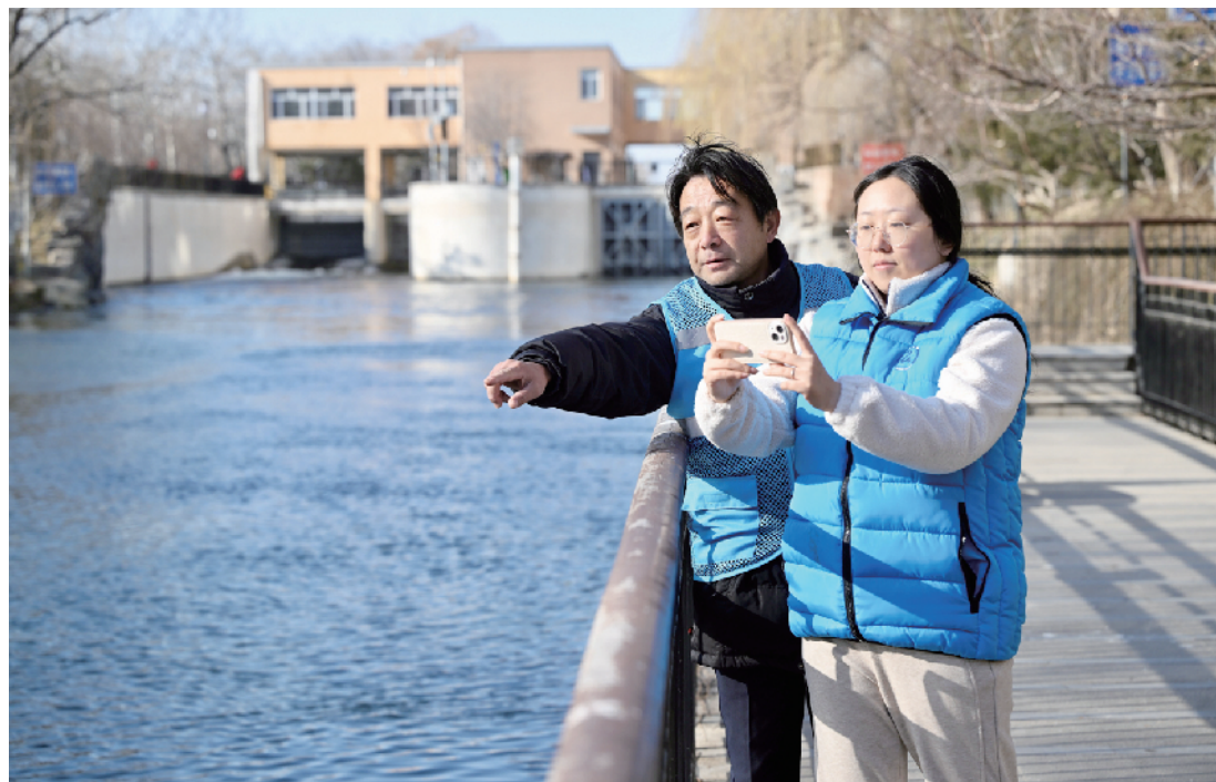
北护城河安定门闸段，工作人员在重点水域巡查
