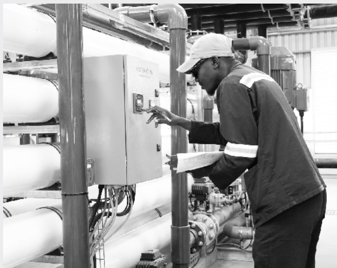
12月16日，工作人员在博茨瓦纳博泰蒂供水项目的水处理厂内检查设备
