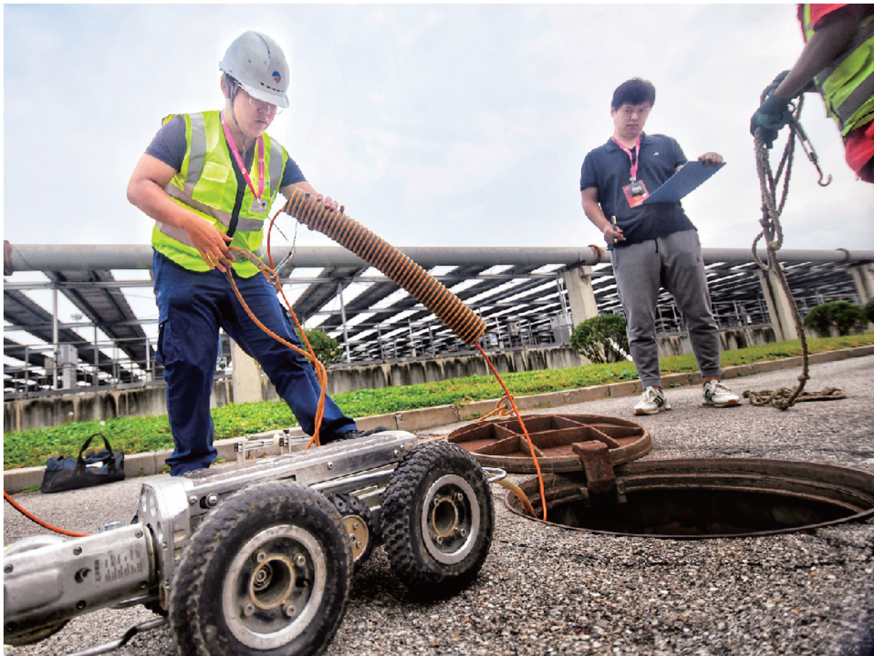
选手调试检测机器人准备送入井下
