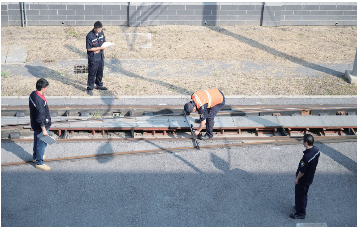
轨道维修专业选手正在进行道岔检查考核
