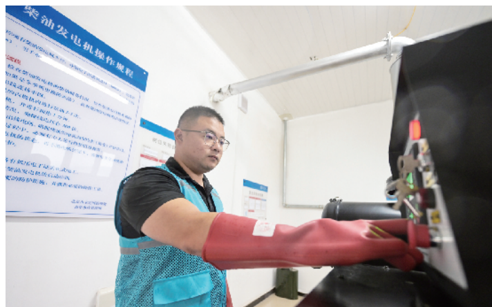
汛期，发电机房的柴油发电机每周试运行一次，确保机闸顺利运行
