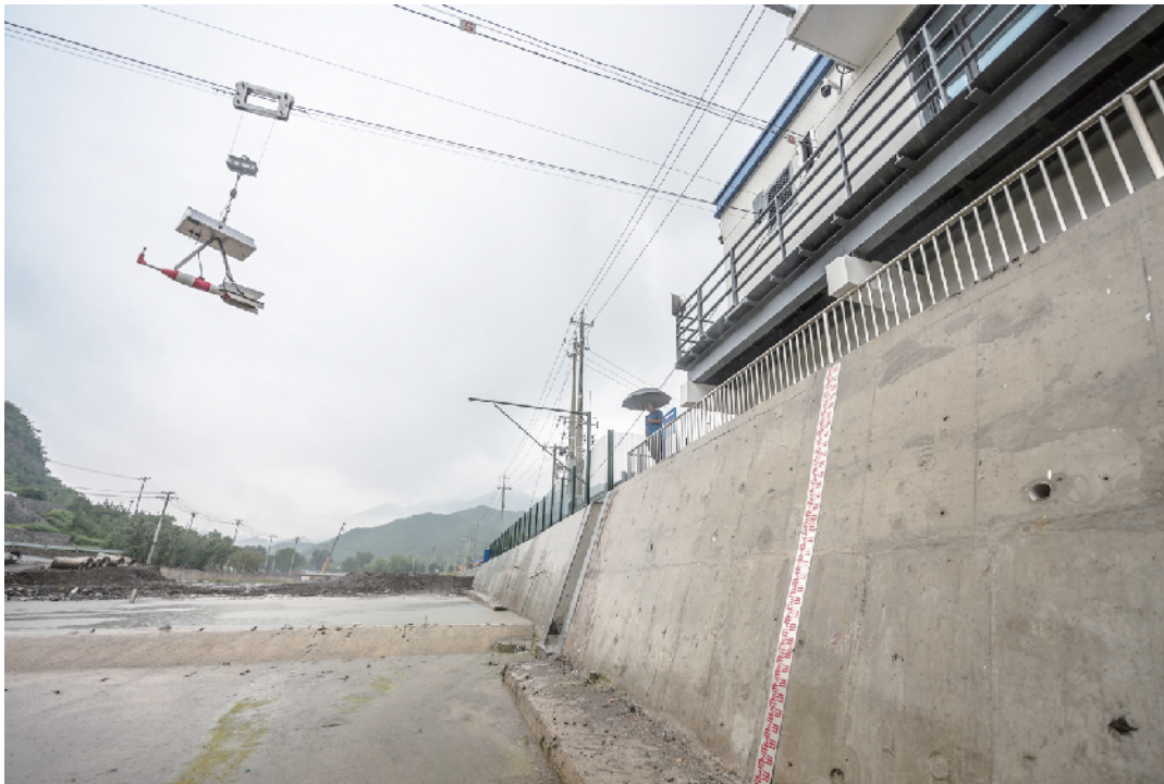
全新修复升级的清水水文站增设了移动雷达波测流系统，实现远程控制、实时监测
