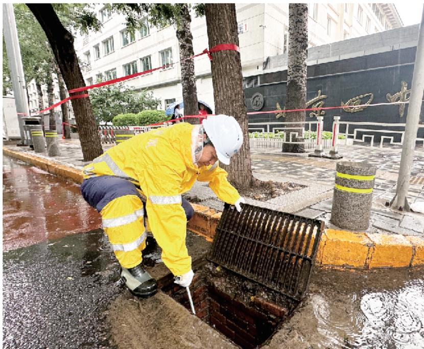
员只能在狭窄的空间内用锤子等工具将水泥一点一点敲击下来，像雕刻一样，纯手工操作。敲下来的水泥碎块装桶，用绳索吊出雨水井，再装袋。“整整一夜，最后清出了十几袋水泥。如果不清理，这就是隐患，到了汛期，北二环辅路就可能积水，影响通行。”
