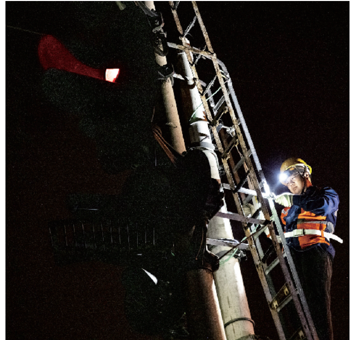
突击队员紧固信号机地线，严谨施工
