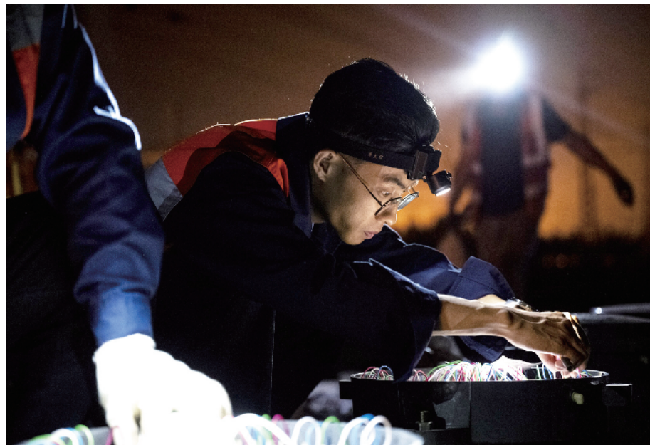
突击队员利用夜间停运间隔对电缆盒进行修整
