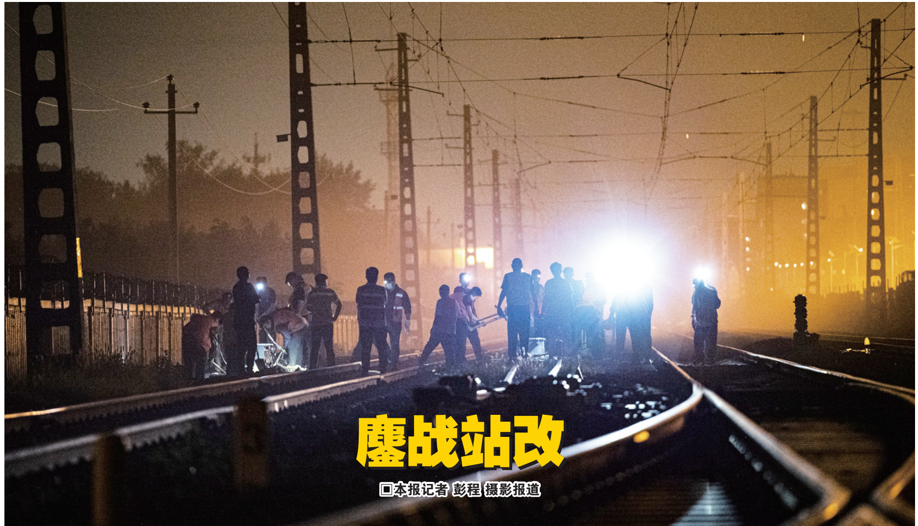
突击队员挑灯夜战，撤除旧式信号设备
