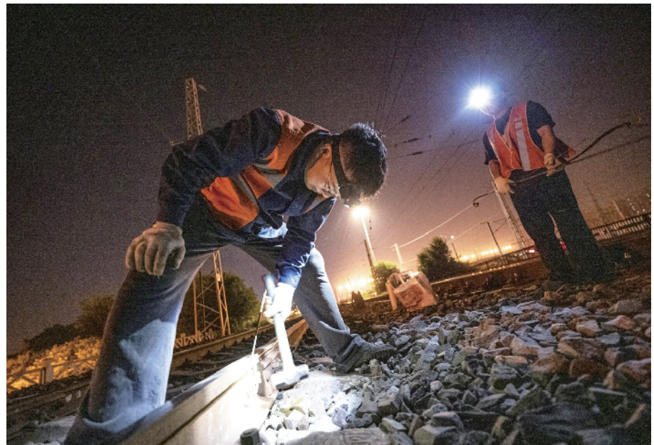
突击队员去除旧线更换新线
