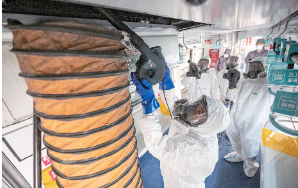
作业人员启动高压吹风机对空调内部部件进行初步除尘
