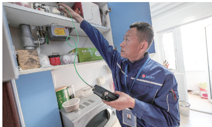
对每根管道的接缝、燃气表前和表后的阀门进行检测
