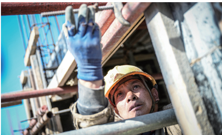
调整支撑架体
