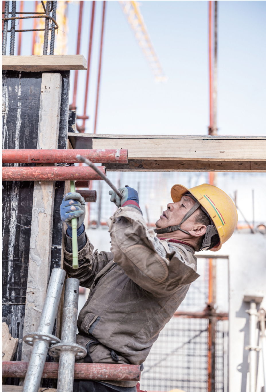
对模板支撑架体进行搭设
