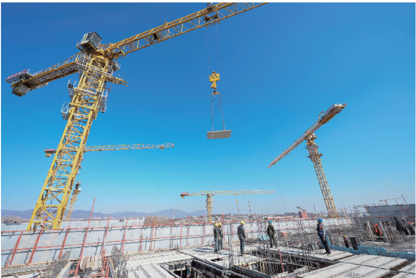
建筑构件平稳吊装
