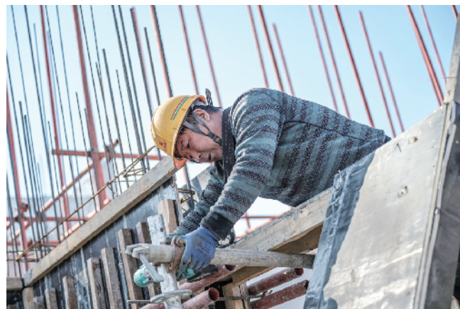
在钢筋外安装木板
