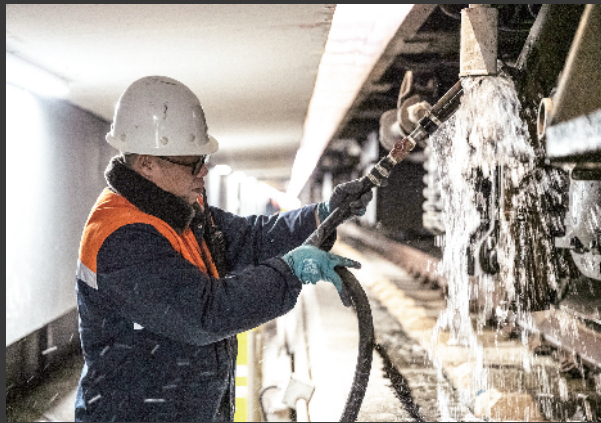
敲掉上水口的冰碴后，首先进行冲洗，洗掉泥污和沙粒
