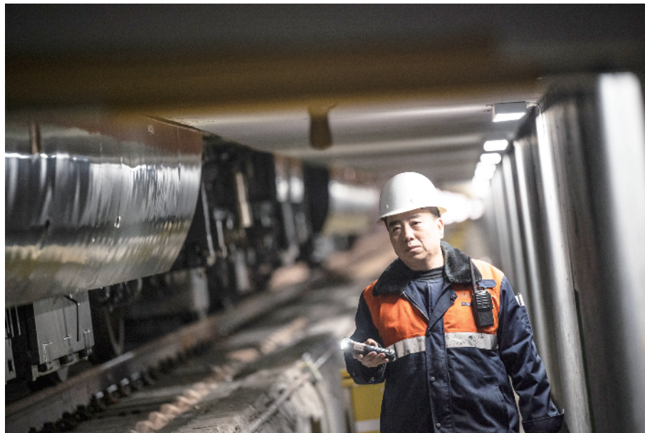
李月武手持复检记录仪拍摄所有注水口，避免出现安全隐患
