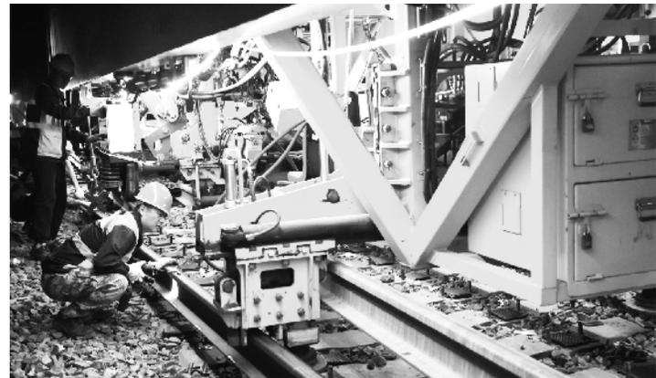
金秋九月，秋高气爽，正是一年集中修施工的黄金季节。近日，丰沙下行线旧庄窝东站至官厅西站间缓缓驶来一辆“大黄蜂”，鸣笛阵阵，响彻山谷。从高处俯瞰，群山耸翠，树木幽绿，“大黄蜂”HGCZ-2000型机械换轨车通体金黄，一群“黄马甲”各司其职在线路两侧忙碌。这里正在进行的，是中国铁路北京局集团北京工电大修段承担的丰沙线换轨集中修施工。
