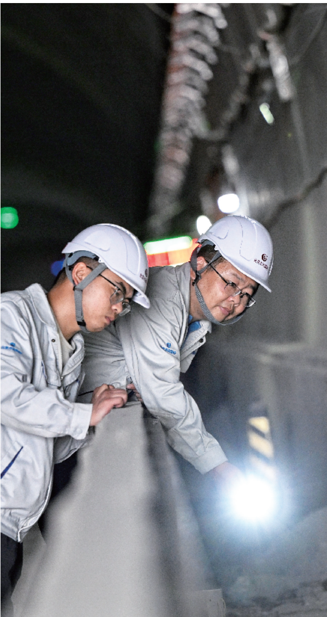
张鹏检查施工进度
