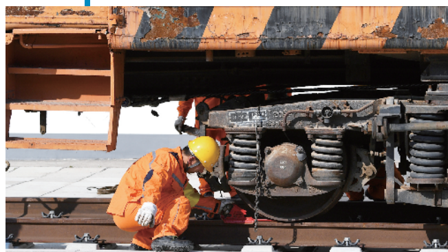
放置阻车器，以防止吊装时车厢发生位移
