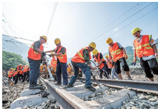
悬空的钢轨下方已经重新填回砂石
