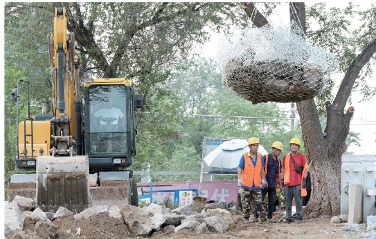
养护人员在河堤上吊放护堤的铅丝网笼
