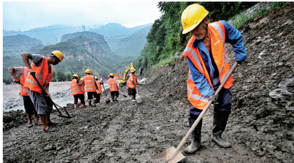
为了尽早清通道路，养护职工在闷热的环境下紧张施工
