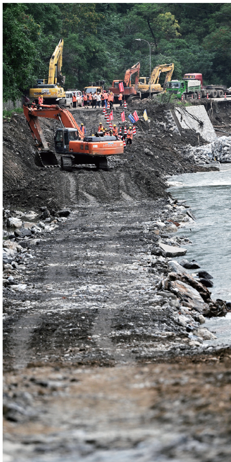
养护职工在断路处施工
