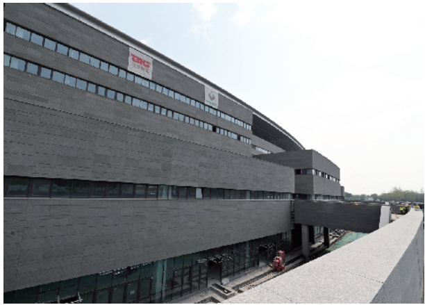
主楼内侧石材幕墙美观大气
