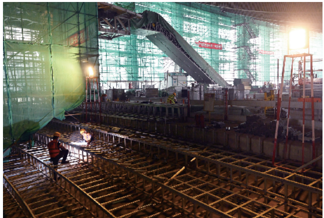
施工人员进行台阶龙骨
