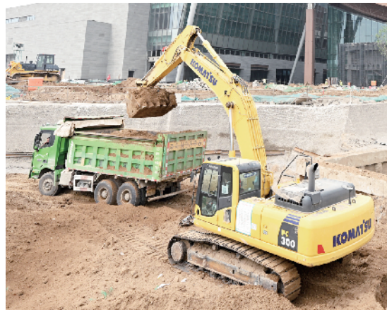
室外园林正在进行土方施工
