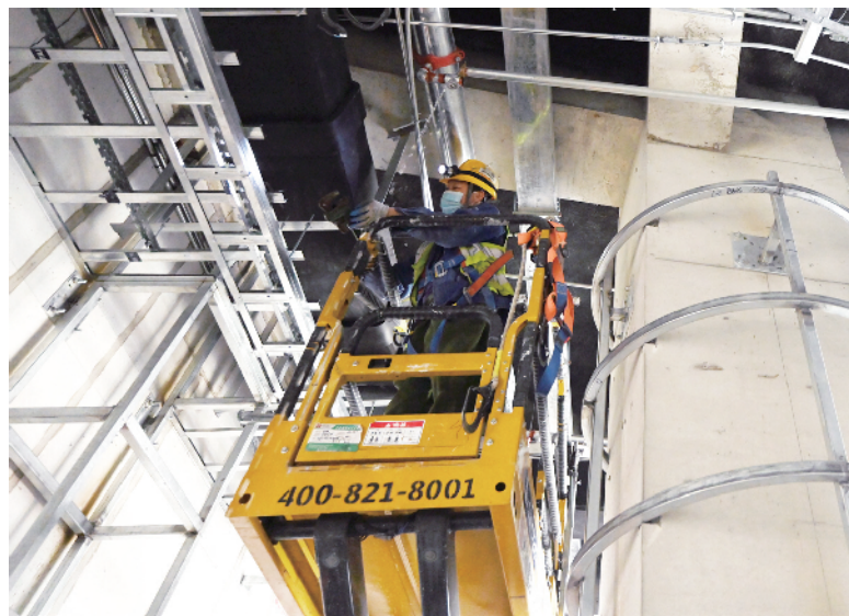
施工人员进行机电管线打压试水
