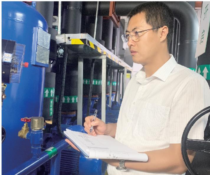
日久、维护保养不到位，发生了锈蚀。姜智旭深知，安全阀在换热系统中的作用举足轻重，可更换安全阀需要大量经费。他立即组织工程技术人员研讨，经过多位专业人员判定：安全阀使用年限过长，并且阀体锈蚀，已不具备安全使用条件，需要立即更换。最终，顺利促成安全阀的更新工作。
