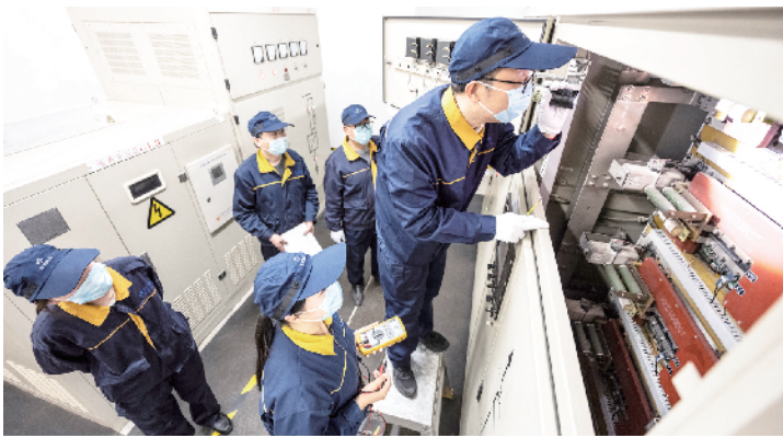
夜里12点到凌晨4点左右，进行检修维护工作
