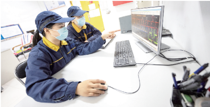
值班员进行远方巡视工作，确认供电设备的运行状态
