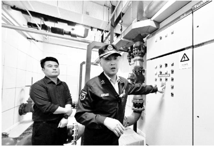
巡查记录和值班记录。“每天要测试电台，与属地消防站进行联系，保证电台畅通。”张桐说。联合执法人员还来到喷淋间，检查了水喷淋末端放水装置、阀门、放水接头、压力表和排水管是否正常。
