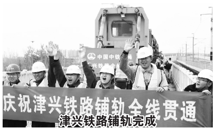
昨天,随着500米长钢轨平稳铺设在胜芳右线特大桥桥尾,标志着津兴铁路铺轨工程全部完成,为年内开通运营奠定坚实基础。津兴铁路全称为天津至北京大兴国际机场铁路,东起天津西站,西至大兴机场站,全线长度100.79公里。 本报记者 彭程 摄影报道
