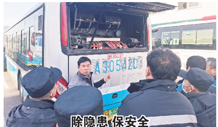
日前，北京公交集团电车分公司第十四车队工会开展“除隐患、强治理、保安全”安全生产大检查。在五路居、三路居等各个场站，工会组织职工代表、管理人员开展机电安全综合检查，开展消防演练，确保设施完好。本报记者 崔欣 通讯员 张鸿源 摄影报道
