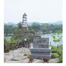
史。古塔为砖瓦结构,塔底直径3.44 米,塔总高23.28米,塔身通高约18.28 米。塔身呈八角面体,套筒式结构, 分为内墙和外墙两层,内外墙用青砖 砌成螺旋状阶梯,逆时针盘绕直至顶 部,把内外墙连成一体。塔底层南面 和西面各有一拱门。从第2层起,自北 向西、南、东方向,依次逐层开9个拱 形窗。内墙为青砖砌圆筒体,层与层 之间用木板铺隔。顶部有大梁和刹木 杆支承塔顶。塔顶八角处各悬铜风铃 一枚,江风吹来,铜铃叮当作响,悦 耳动听,声闻十里。顶端置铸铁覆钵, 经数百年风吹雨打,仍未生锈,也算 是一奇迹。
