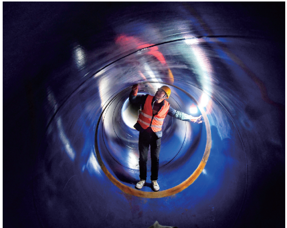
工人在钢管内巡检
