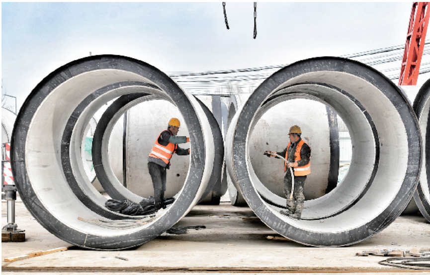
▲工人正在给顶管安装注浆管路
