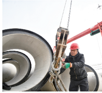
工人安装起重设备
