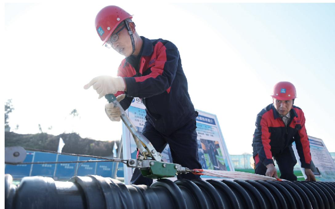
时操作“上药”，喷涂材料在管道内壁迅速反应固化成型，管网修复变得“轻而易举”。过去1个月的工作量如今可缩短至4天完成。
