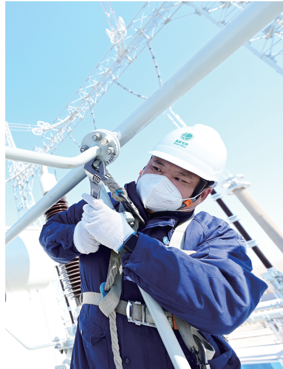
电力职工在安装主变压器附件
