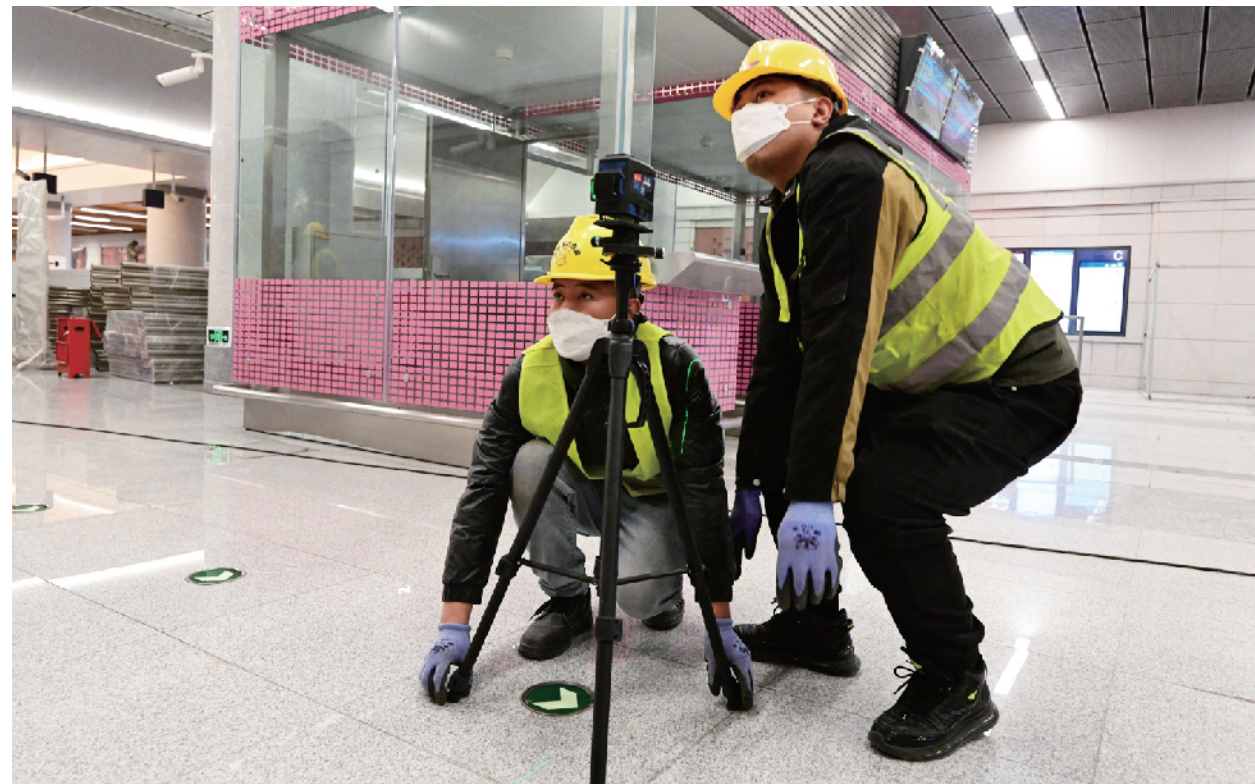
地铁16号线昌平线南延一期工程施工现场，工人们正在作业
