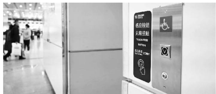
本报讯(记者 盛丽)近日,京港地铁应用新科技持续强化疫情防控工作,在4号线北京南站直梯试点安装了免接触按钮。这是北京轨道交通站点首次应用直梯免接触按钮,该按钮可通过感应触发进而控制电梯运行,全程无接触乘梯,为乘客提供更为安全的出行体验。
