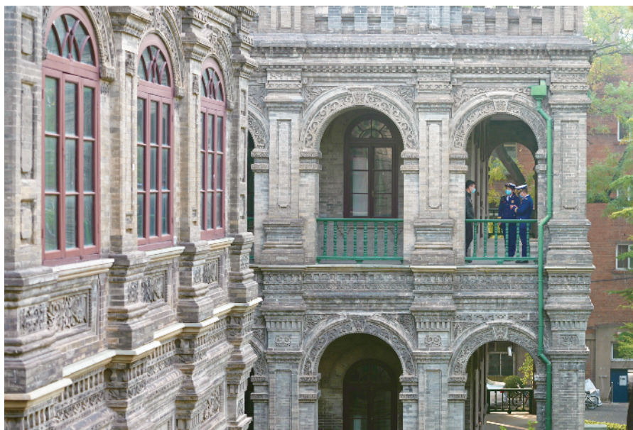
东城区消防救援支队防火监督员检查文物楼内疏散通道使用情况
