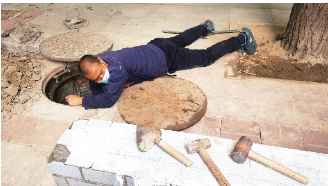
丰益花园物业工作人员铺设小区安全监控线路
