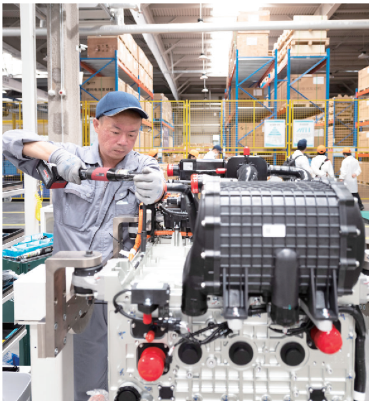
在北京亿华通科技股份有限公司氢能发动机总装车间，工人正在安装设备
