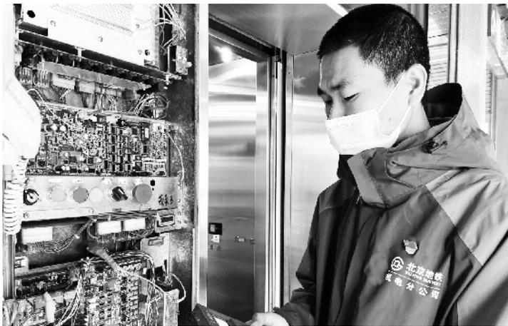
柱在准备更换轿顶导轨时，发现液压电梯可以正常开梯运行，却不能转换为检修运行，就意味着大修工作无法正常进行下去。他拿出电路图纸进行分析，在电梯机
