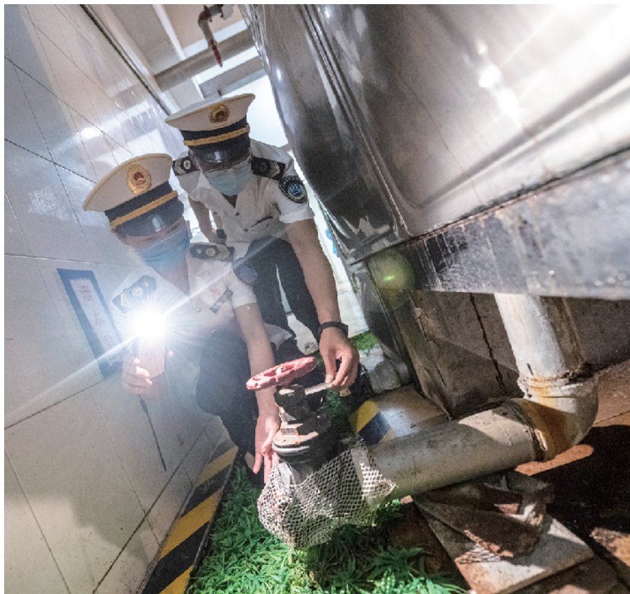
在闷热狭窄的地下供水设备间检查安全情况
