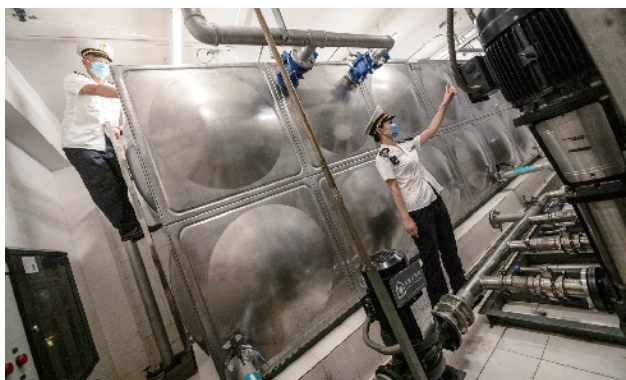
检查设备间的水箱管道等设备
