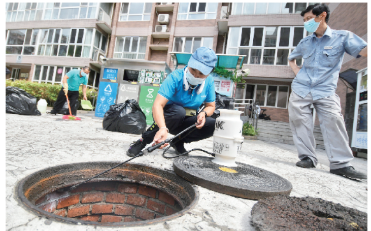
保洁人员定期为雨水井消毒
