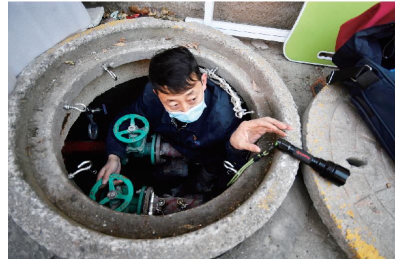
康伟下井检修
