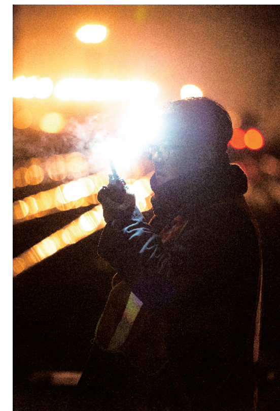
1月1日凌晨,宋英鑫正在进行施工作业
