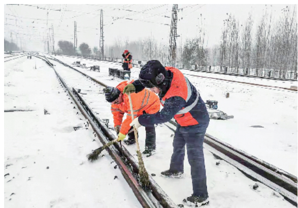
北京西电务段出动600余名职工,采用吹雪机、扫帚等工具,对道岔设备随下随清,确保列车安全运行
